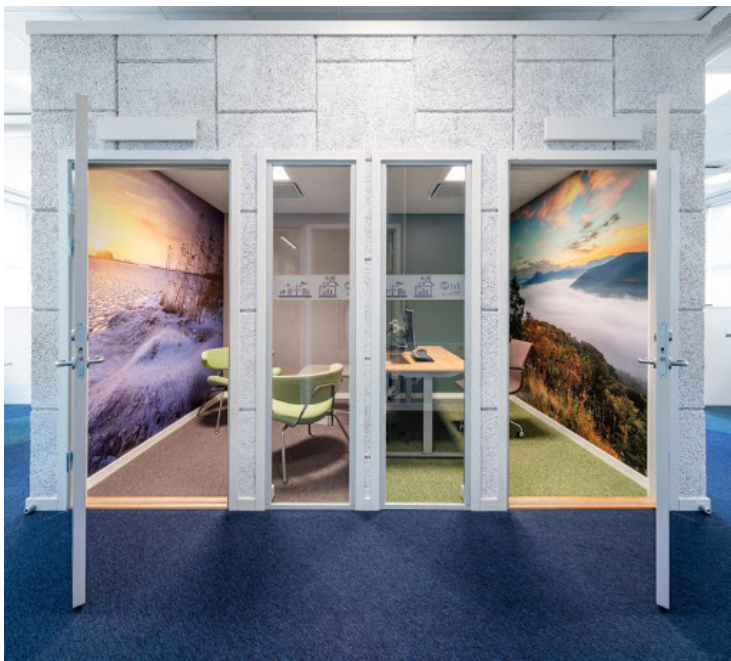
Återbrukat undertak som väggklädnad på IVL:s kontor
